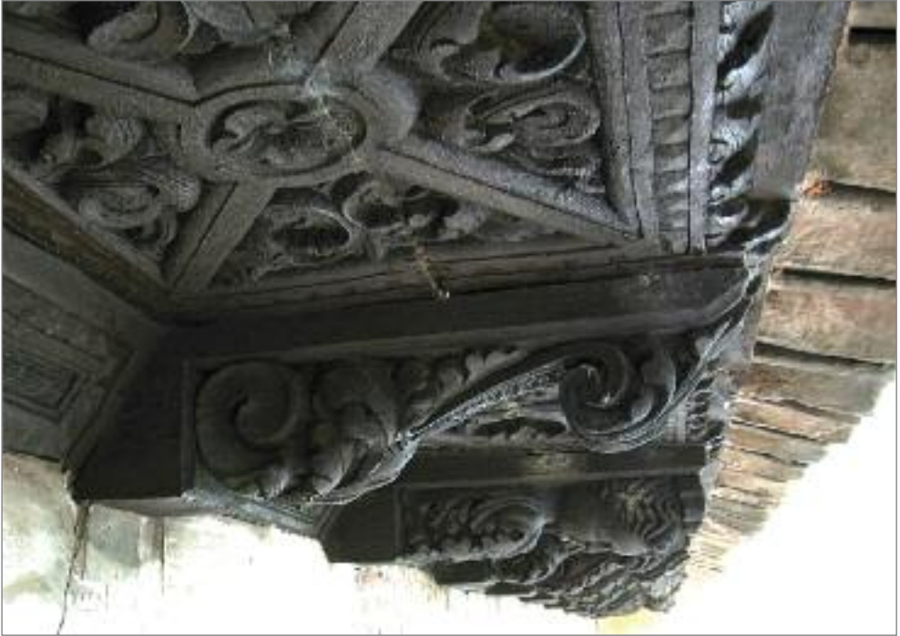
Figura 4. Vista lateral de los canes del alero de la casa de los Monterde.
