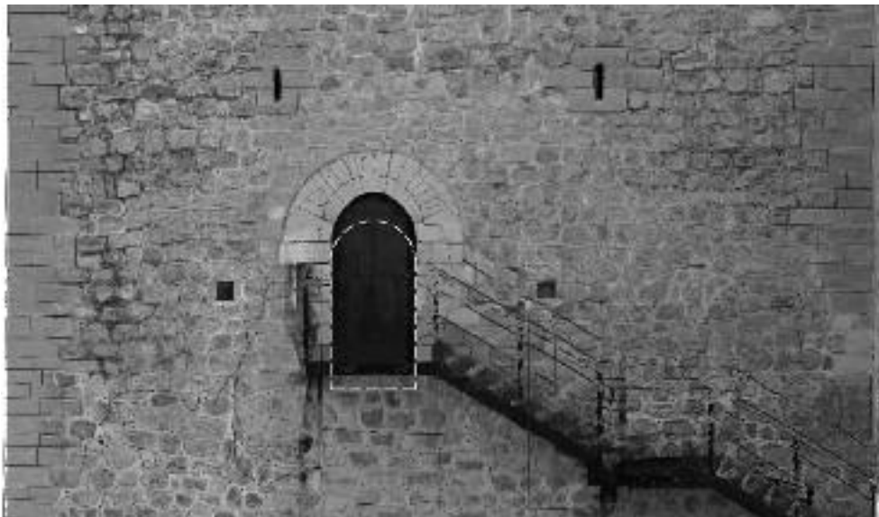
Figura 7. Superposición del alzado de la puerta antes de la restauración y de la ortoimagen posterior a esta. (En trama el salmer del arco que se conservaba y en línea blanca de trazos la posición original de la puerta).
