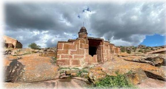
El interior está cubierto por una bóveda de arco rebajado que en el exterior presenta un aspecto de techumbre a dos aguas. Sobre la cubierta hay una pequeña torre de planta circular y construida en sillería de alrededor de 1,8 metros de altura. Tiene dos molduras decorativas, una en el remate
