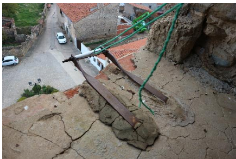
Pieza metálica dispuesta en el campanario de Jabaloyas para repicar la campana grande desde el exterior.
