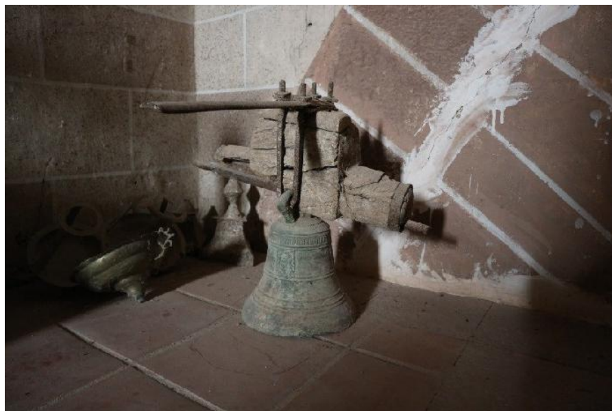
Instalación para oscilar del campanillo gótico de Ródenas.
