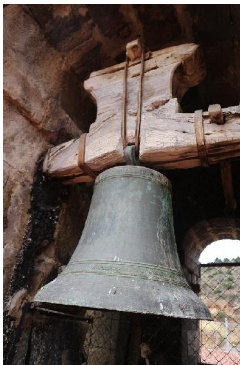
Instalación tradicional de la campana grande. Iglesia parroquial de Monterde de Albarracín, con la fecha de 1785 en el yugo.
