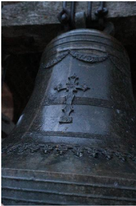
Cruz extraída de un único molde. Campana Asunción de la Iglesia parroquial de Saldón (1944).
