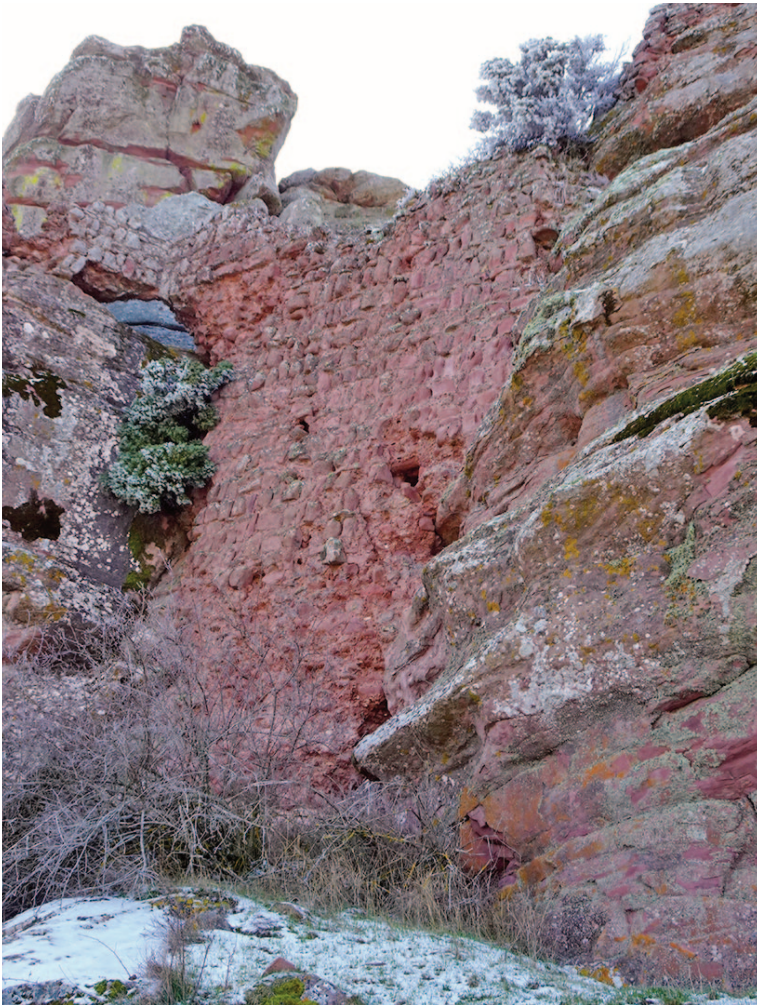
Potente muro de la fortaleza andalusí, con sus sillares desgastados por la erosión
