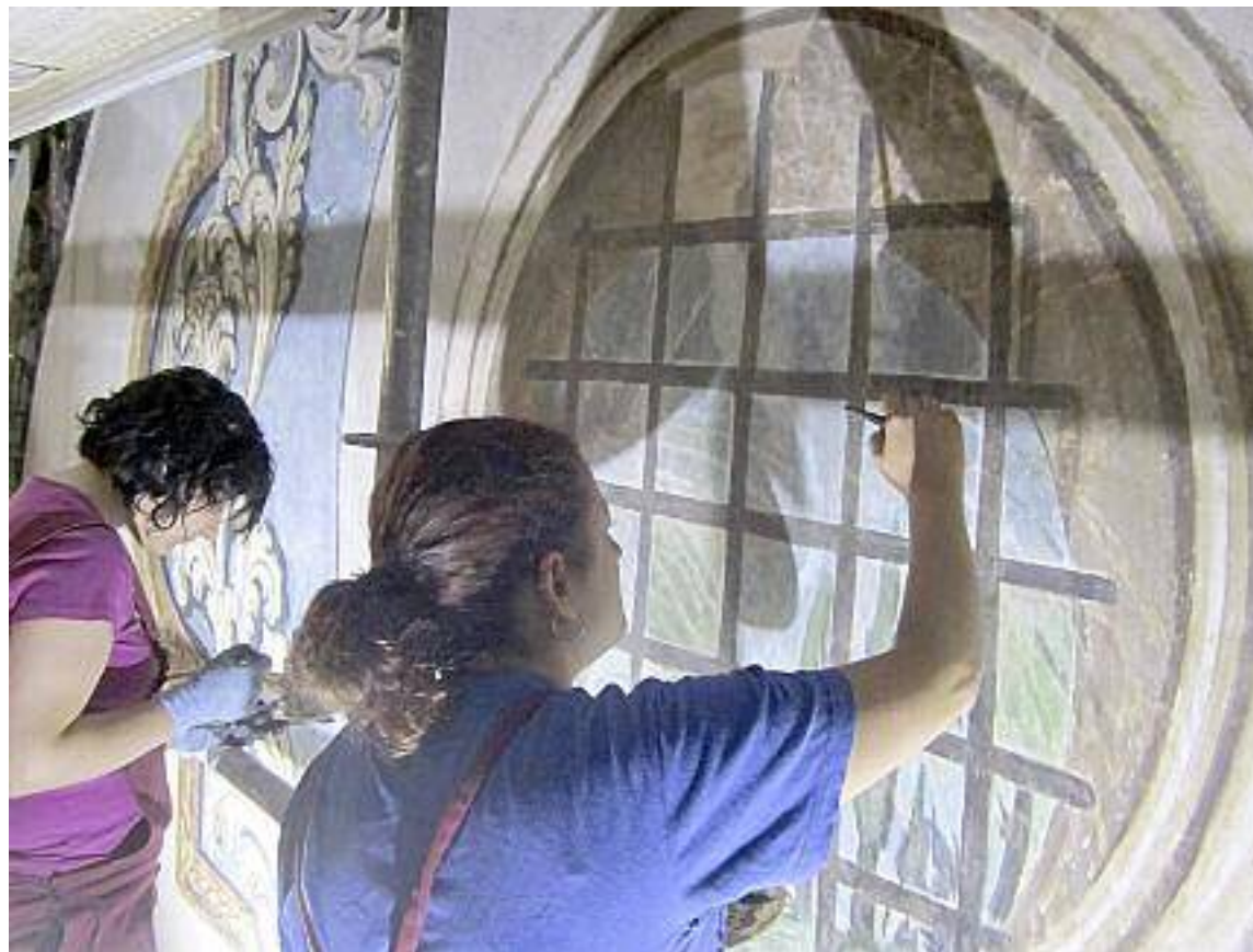
La Fundación está trabajando ahora en la restauración de la Catedral de Albarracín. Fundación Santa María
